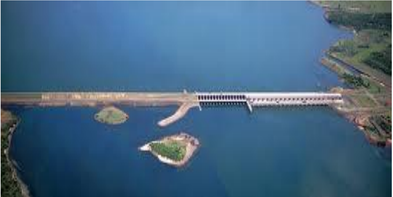
Usina Hidrelétrica de Porto Primavera – Rio Paraná
